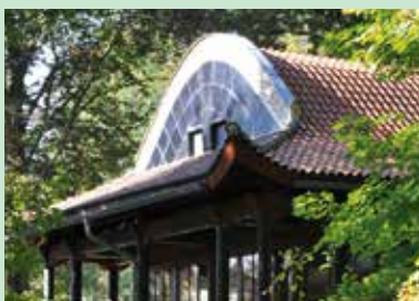
Dach und Ostgiebel 2010
